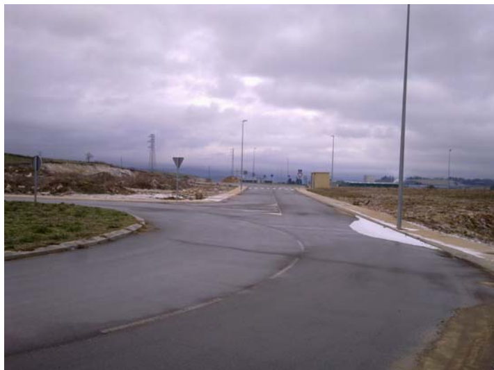
Fotos 1 a 4: Imágenes del estado actual de la última ampliación realizada.
